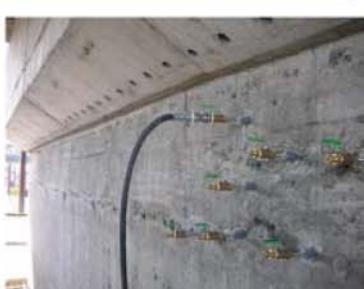
ハンマードリルによる穿孔後、注入プラグを取り付け、充填
