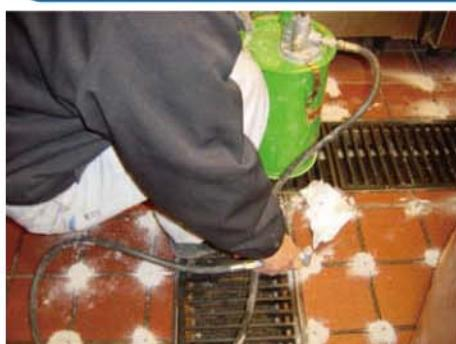
漏水箇所、規模によりプラグを増やすが、規模の大小に係わらず同じ工法で施工できます
