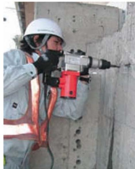
亀裂箇所やエフロ漏出箇所をチェックしハンマードリルで穿孔する。
