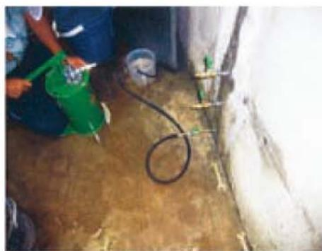
〈参考〉漏水していないクラックの場合先行注入は水で行い、漏水している場合はSHを注入、更にGHを注入する。
