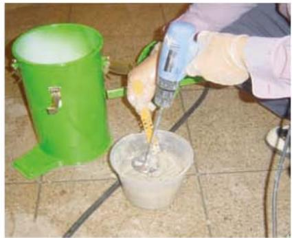
注入剤高炉スラグに清水で馴染ませGHを混練りする。更にSHでペースト状にして注入剤とする。
